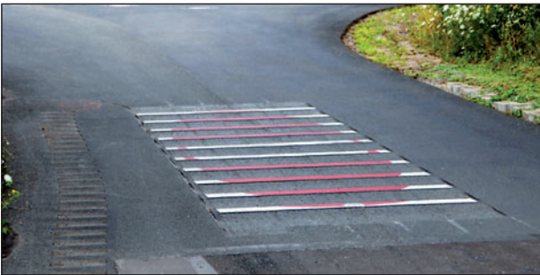
Bild 21: Rüttelstrecke von 6,70 m Länge und 2 m Breite mit 3 cm tiefen Einfräsungen.
